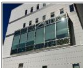
太陽光セル埋込窓ガラス採用
