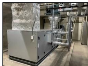
セントラル空調機更新
