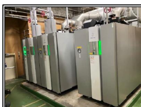
ボイラー更新
