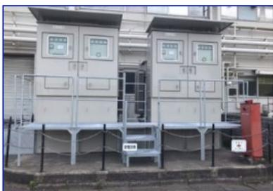
電気設備の高上げ洪水対策
