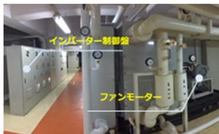
循環空調機へのインバーター制御導入
