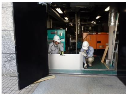
水害防止として防潮板設置訓練
