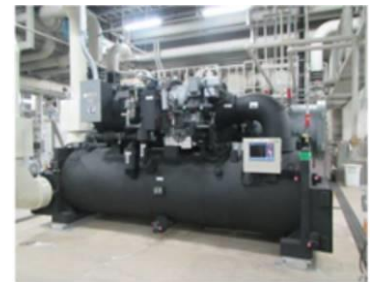
高効率ターボ冷凍機への更新
