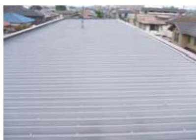
屋根の断熱塗装
