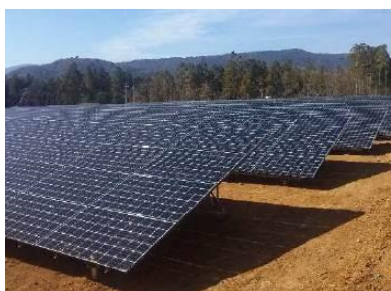
メガソーラー発電所の施工
