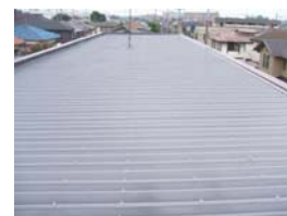
屋根への遮熱塗装
