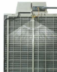
室外機への水噴霧
