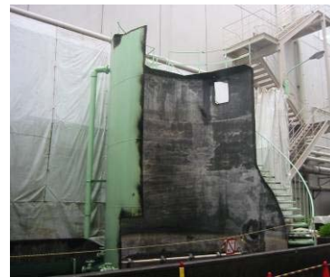
造排水設備撤去
