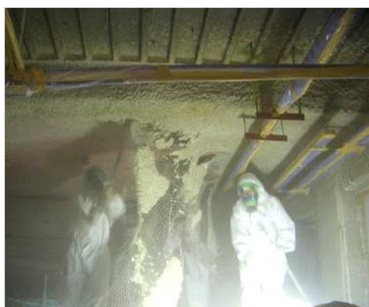
石綿除去作業(レベル1)
