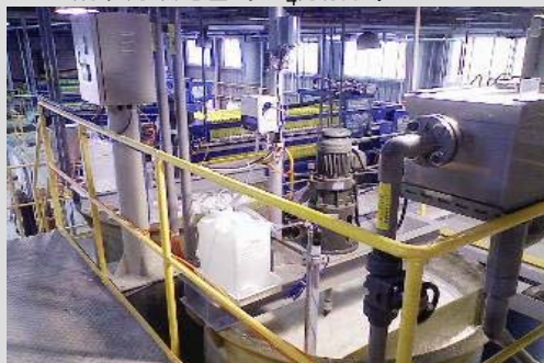
凝集沈殿処理 (BF 4 分解後)
