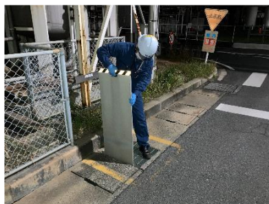
側溝への止水板設置訓練
