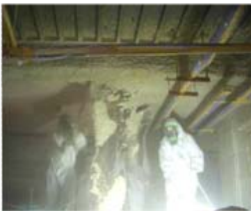
石綿除去作業(レベル1)
