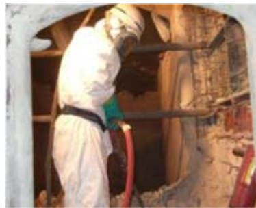
焼却炉解体作業(レベル2)
